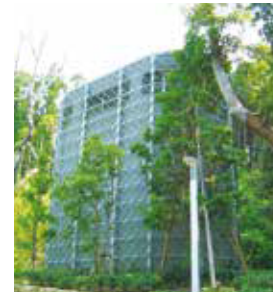
建物の外にある空気を取り込む設備
