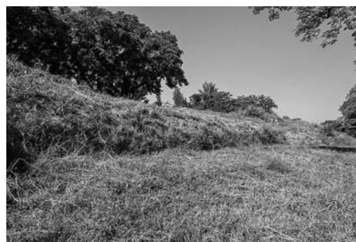
u 3 シルスフ城壁址
