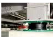
层压橡胶隔离器 (147个)
