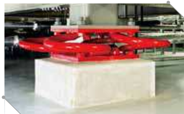
揺れ幅を減衰させる「鋼棒バンパー」
