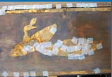
金箔の剥落止め。今後も伝えた技術を活用できるように、現地で入手可能な材料を使用しました
