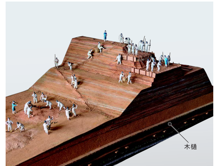
水城模型 (No.22) 水城は棒で土を突き固めて築いた土の城壁。木樋は導水施設で、城壁の地下に埋設されている。
