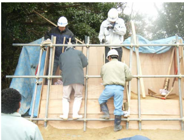
試験盛土の状況（平成17年）
