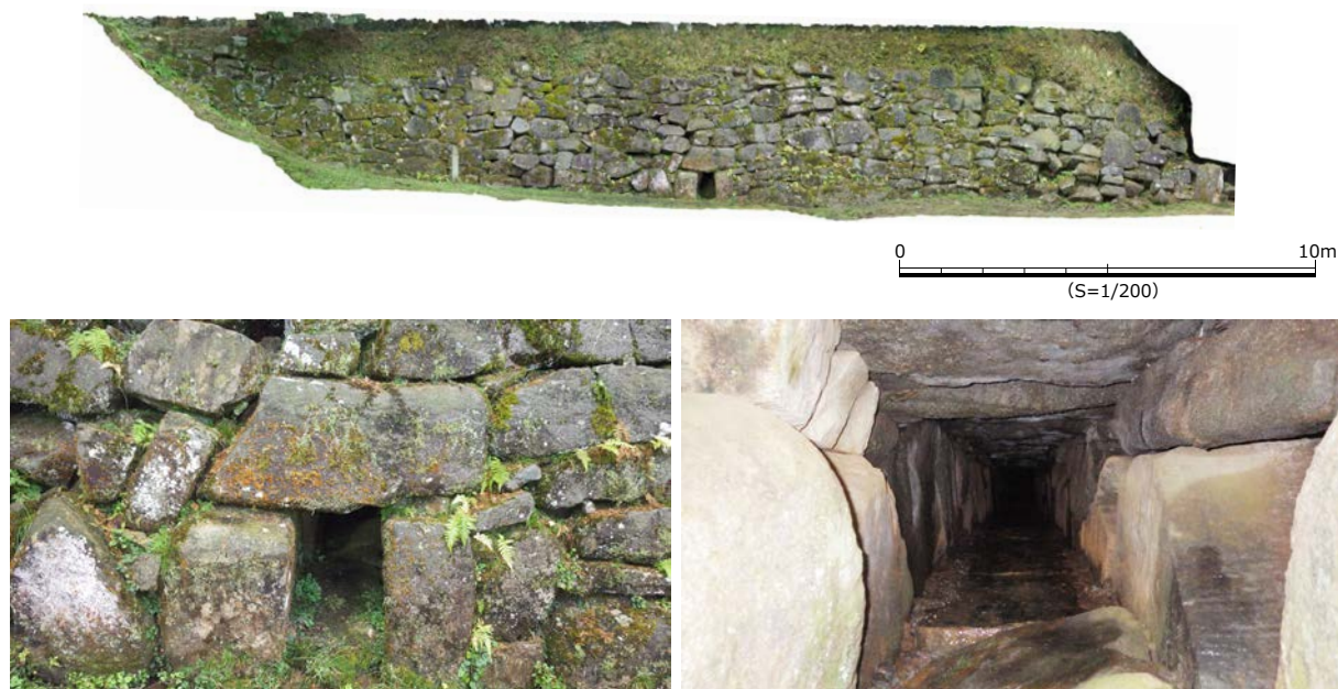
図6 石城山城北水門の構造（上段：A面オルソ画像、下段：通水施設とその内部）
