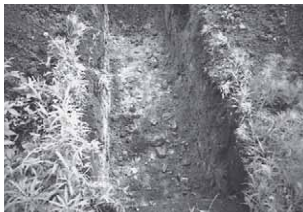
写真 5. トレンチ 2 状況（南から）
