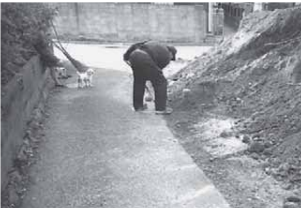
写真 6. 立会調査状況（東から）
