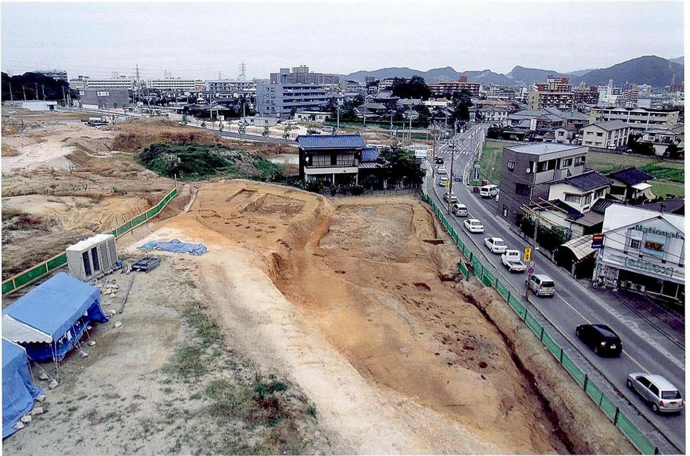
(1) 調査地全景（南から）
