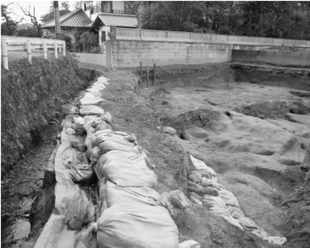
Pla.4-3 馬場遺跡第6次調査 6SX090断割状況（南東から）、左手に現在の藍染川を望む
