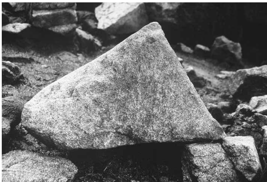
3. 第3水門石塁崩落石 (側面)
