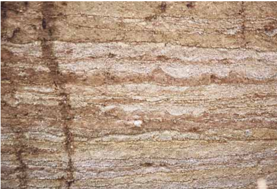
2. 第12トレンチ 版築土層突き固め 痕跡
