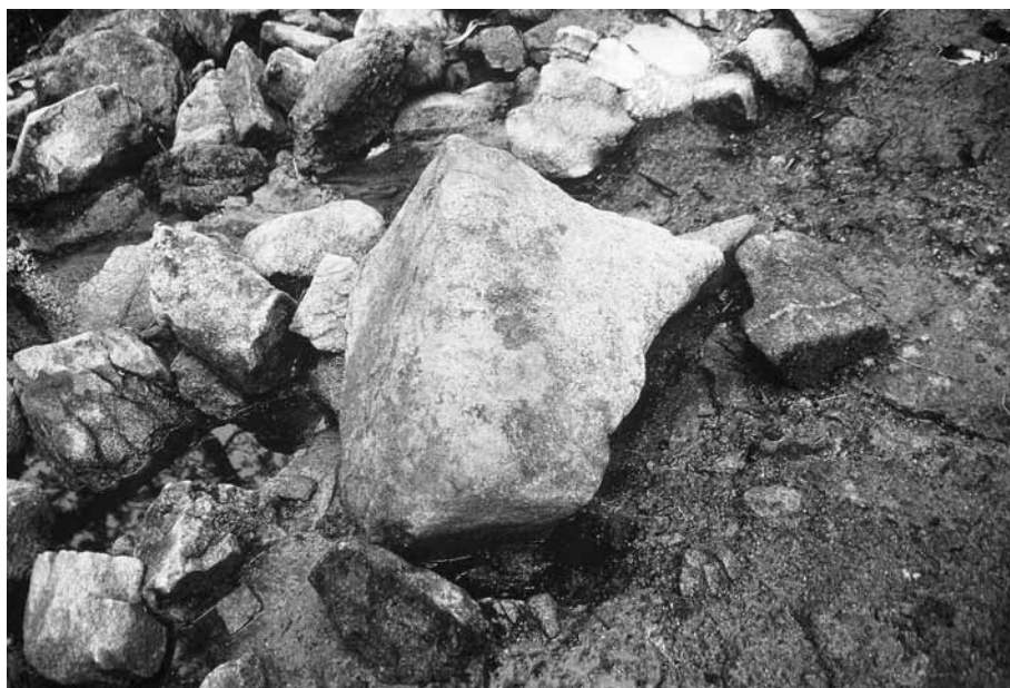
2. 第3水門石塁崩落石 (上面)
