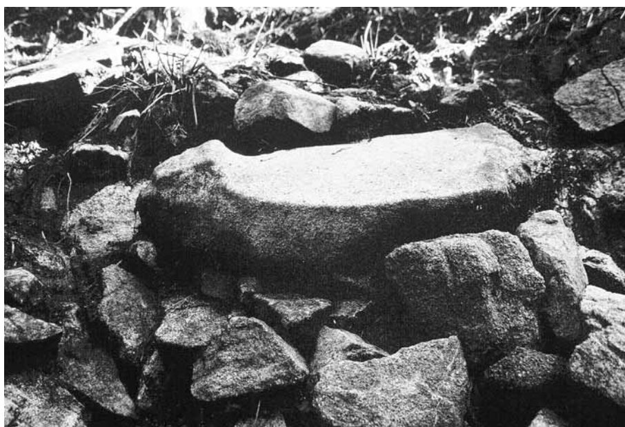
2. 第3水門石壘崩落石
