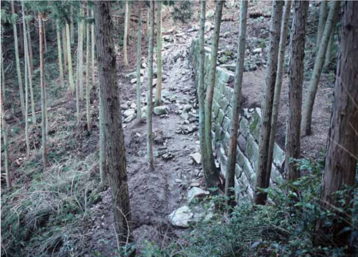
1. 第3水門全景（北西から）
