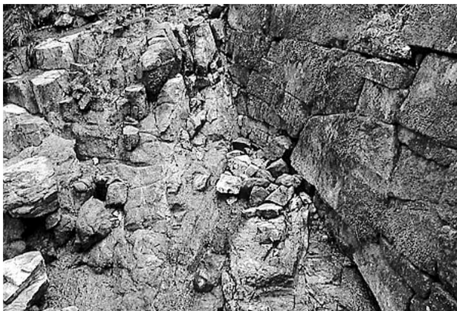
3. 第3水門東端部拡大
