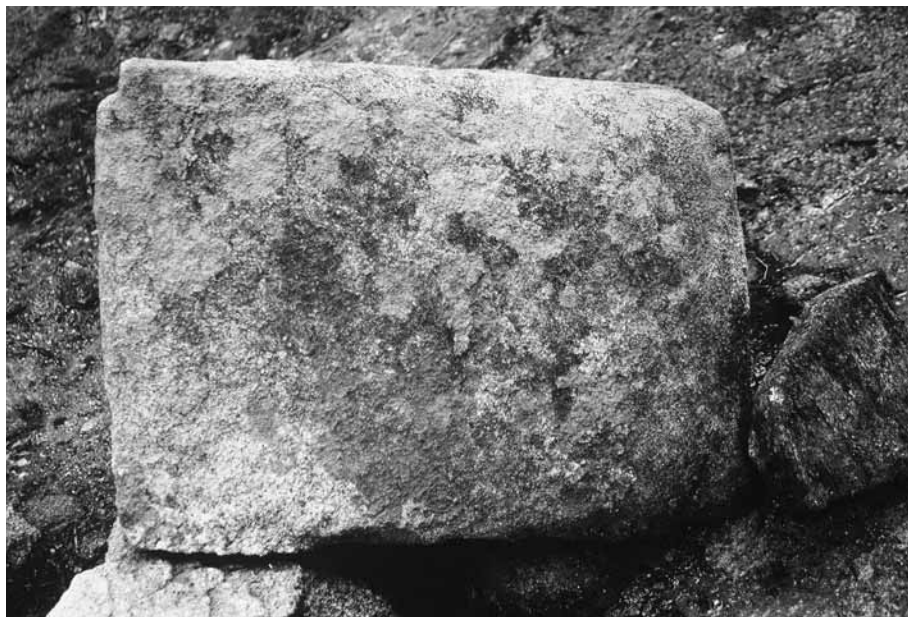
1. 第3水門石塁崩落石 (正面)
