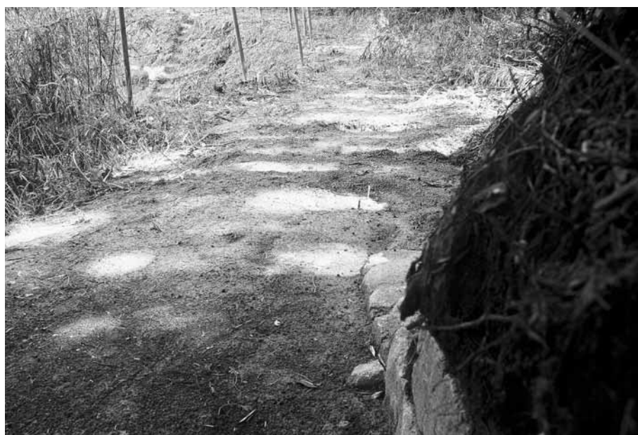
3. 第7地点より 第6地点方向を望む
