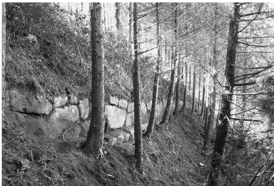
1. 第3地点土塁全景
