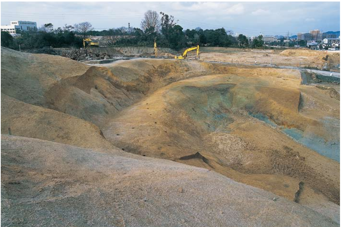
(2) 10次調査区全景（南から）
