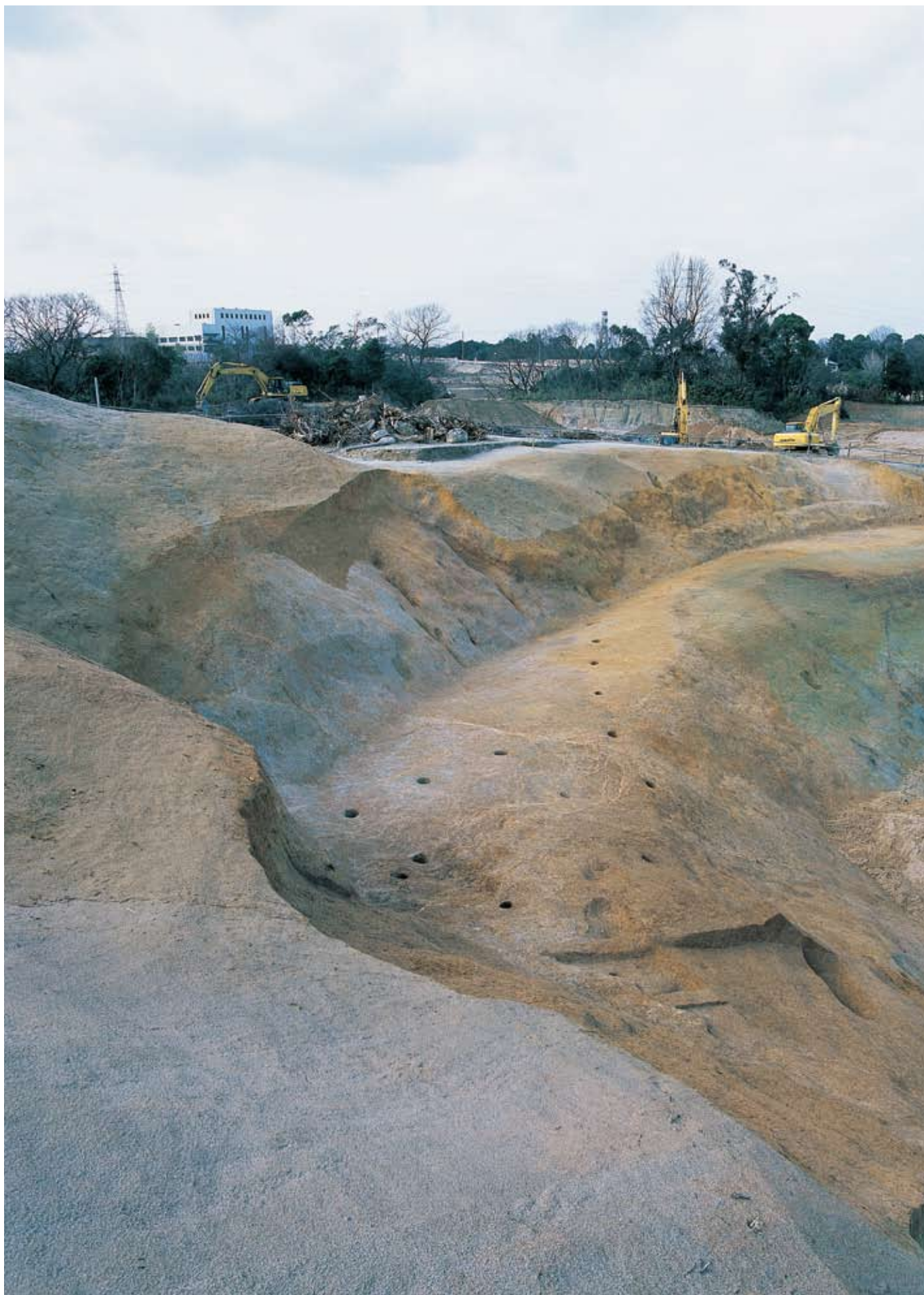
10次SA01・SB01全景（南東から）
