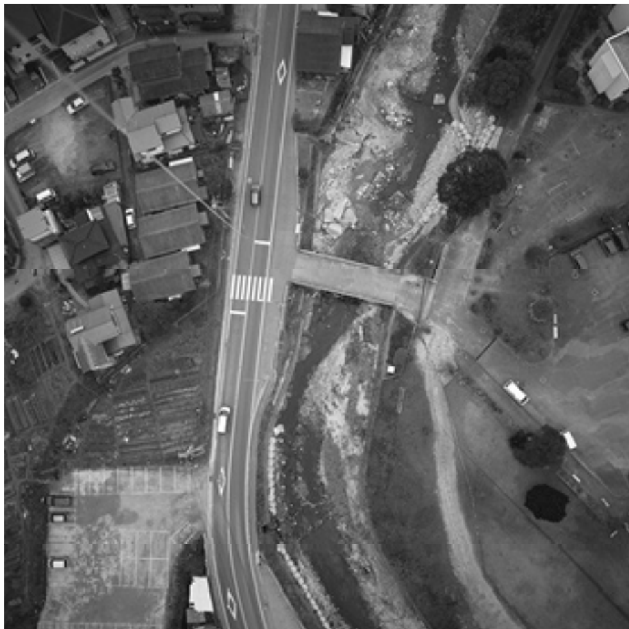
幸ノ元井堰第1次調査全景（右が北）
