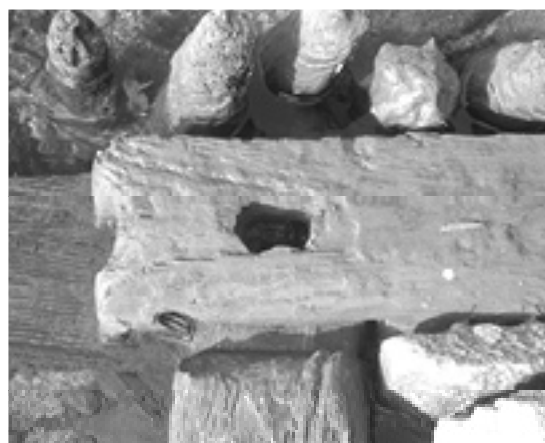
ホゾ穴状況 (SX003e) (東から)
