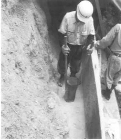
3-9 石積天端を養生し、石積背面の盛土部分を15cm程度の播き出し締め固めを繰り返し造成する。
