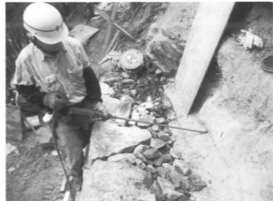
3-⑦地山にアースアンカー埋め込みの削孔を開ける。
