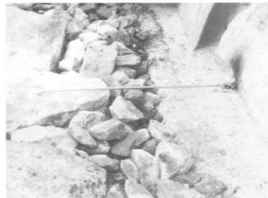
3-⑧地山削孔にアースアンカーを定着させ、石垣内のキーストーンとSUSボルトで繋ぎ定着させる。
