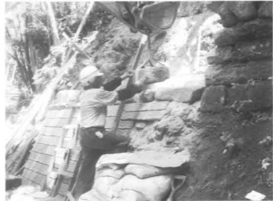
3-⑥仕分け分類した遺構石を基礎部石積の天端に据える。
