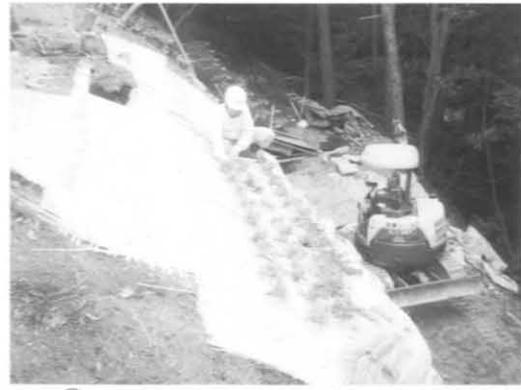
3-13 石垣天端の土羽仕上げの後、侵食防止に修景性を配慮し、コグマザサを植栽する。当面の排水対策としてはワラコモで表面を養生する。
