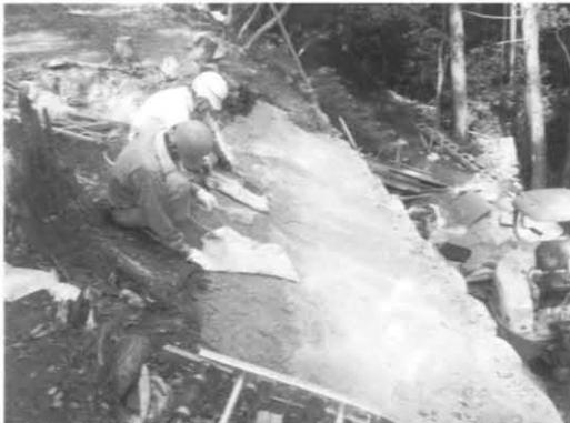
3-11 石垣天端を粘土(石灰混入)を播き出し締め固めた後、土羽整形を行う。
