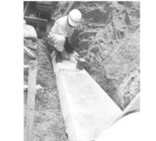
3-④基礎部石積は、中国産御影石厚さ15cmを15段積む。地盤との定着はアンカー打ち込み
