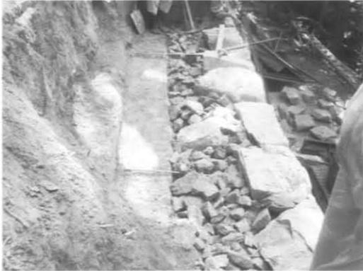
3-10 石積背面の裏込材と盛土、アースアンカーとキーストーンの状態を示す。キーストーンは新たに追加した石垣石である。
