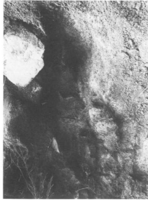
↑写真6：崩壊部北側石垣裏込め詳細（東から）
