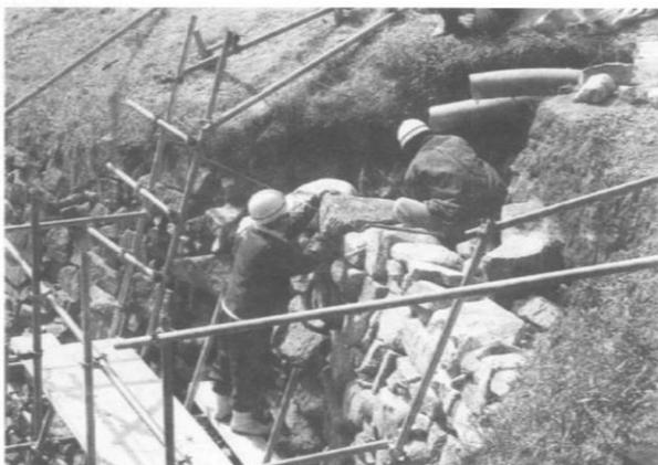
③石垣復旧工：石垣流出箇所の積み直し
