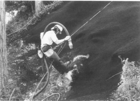
③法面保護工：植生基材吹き付け
