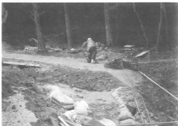
②石垣保護盛土工：土留め用板柵と保護盛土の施工
