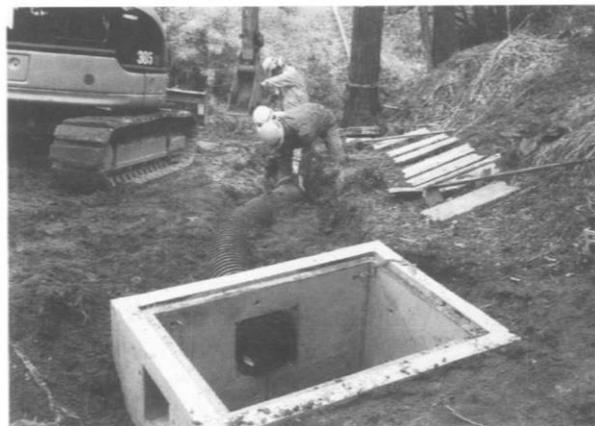
②排水工：集水枡（4-A）とフレキシブル管の埋設
