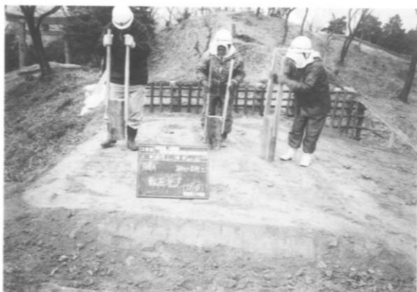
④土塁の復元：版築工法による土塁本体の構築
