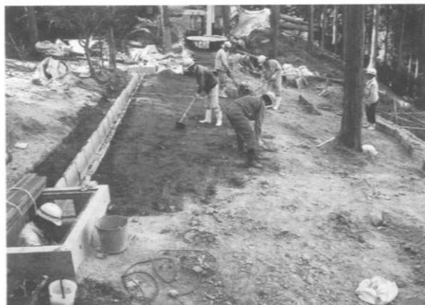
③排水工：排水施設の整備と保護盛土の施工
