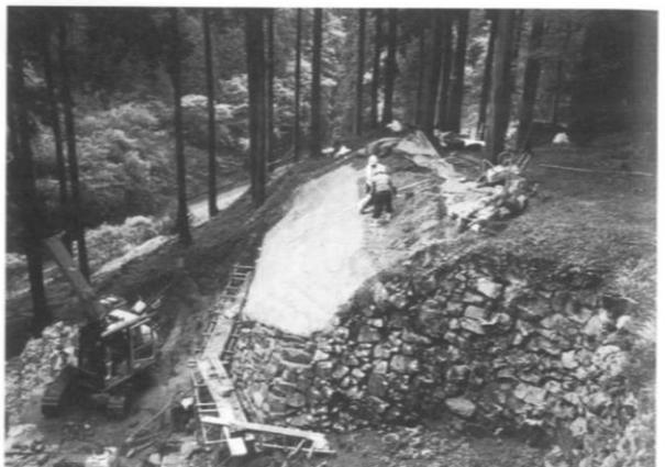
⑥土と石を用いた裏込の施工
