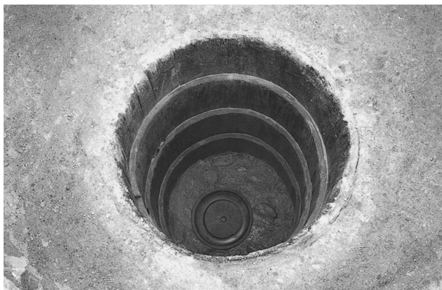
233SE050井戸枠詳細（西から）
