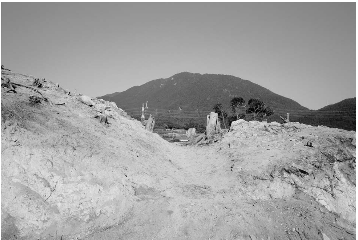
Pla7-2 30SD003 完掘時（西より）
