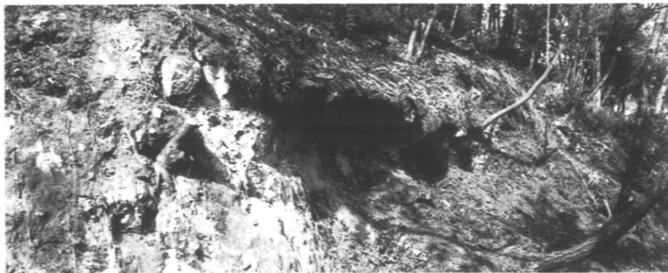
南東部 D地区 列石下崩壊状況
