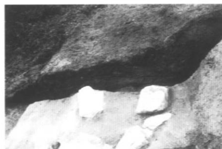
(左下) H15-3トレンチ 列石崩落状況 (中下) 山頂東斜面 列石崩落状況 (右下) H16-6トレンチ 列石崩落状況
