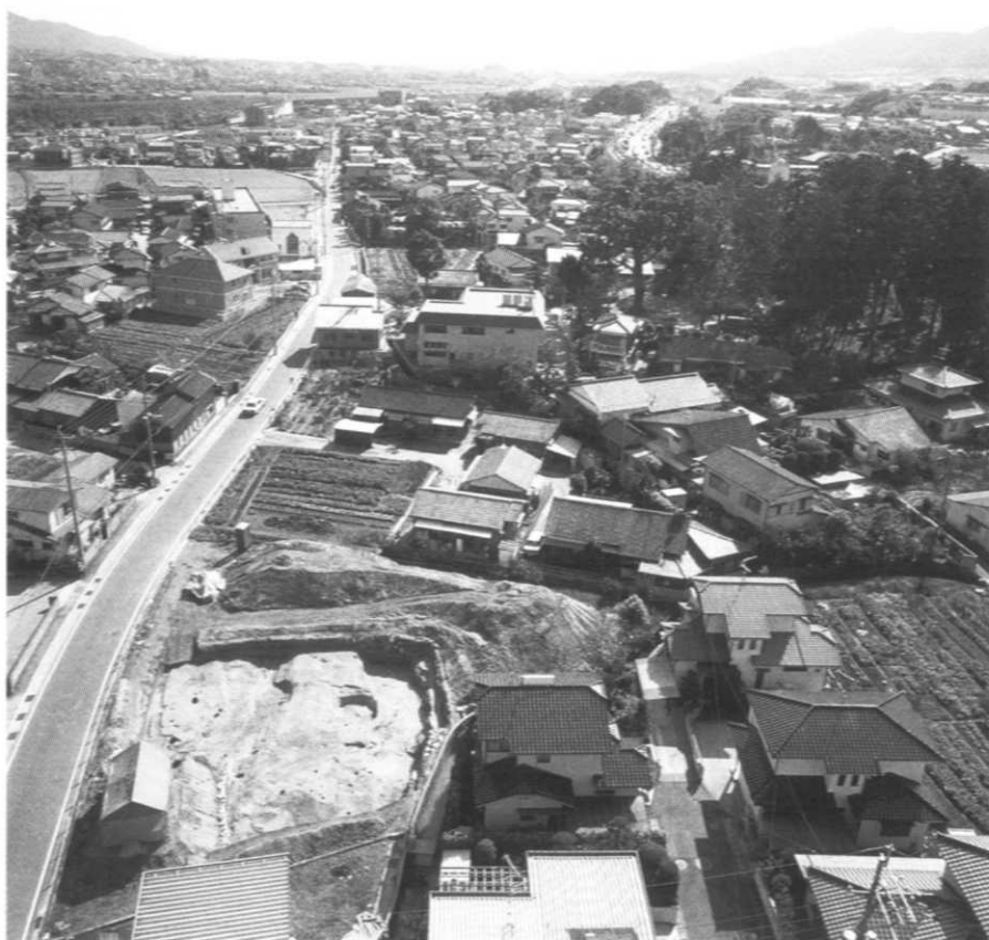
島本遺跡第2次調査区と南東側周辺（北西から）
