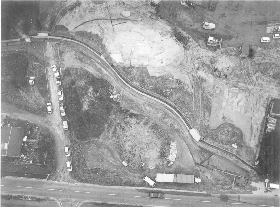
前田12次調査区北側全景（右下が北）
