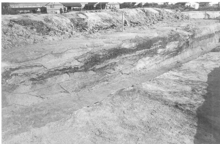
日焼11トレンチセクション（南西から）
