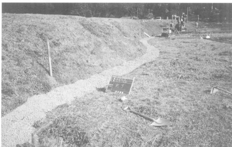
写真13 暗渠排水工布設完了状況 （南西から）
