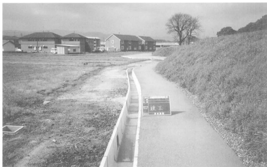
写真21 管理通路完成状況 始点部（北東から）
