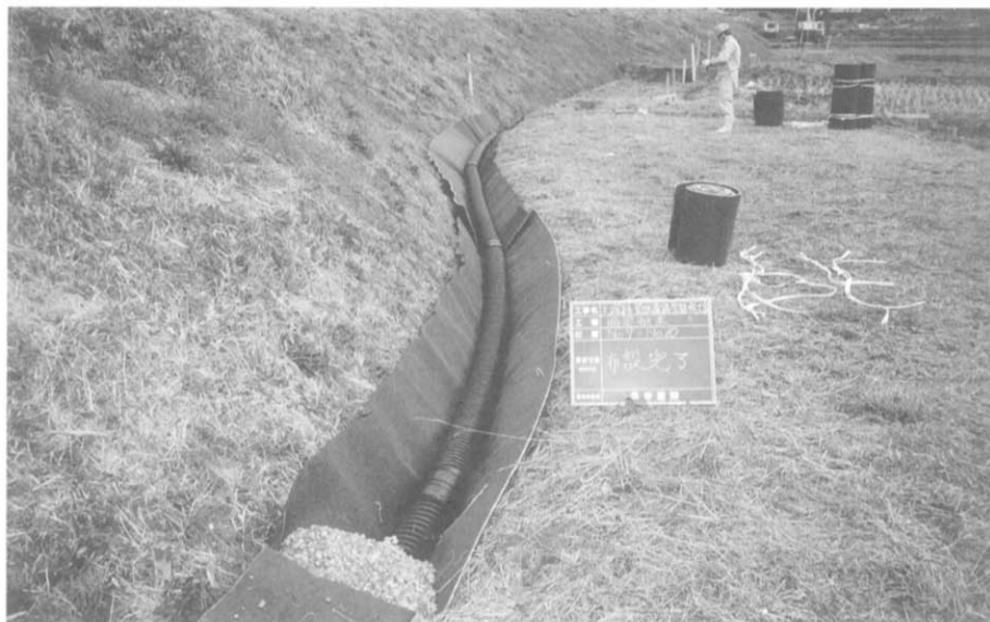
写真11 内径150mm網状管布設状 況（南西から）
