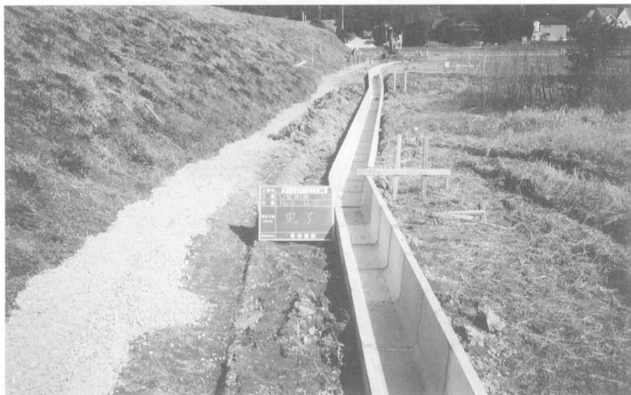
写真14 U字型側溝布設状況 (南西から)
