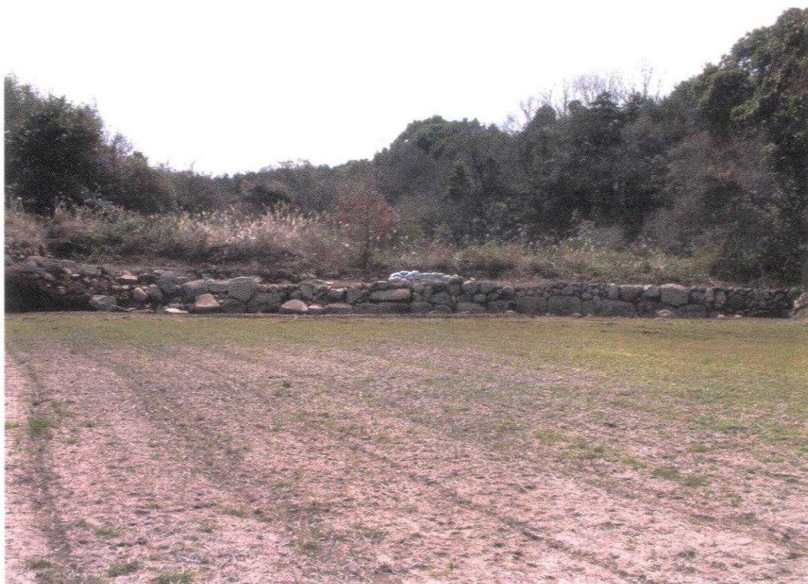
2. 第1水門現況（北から）
