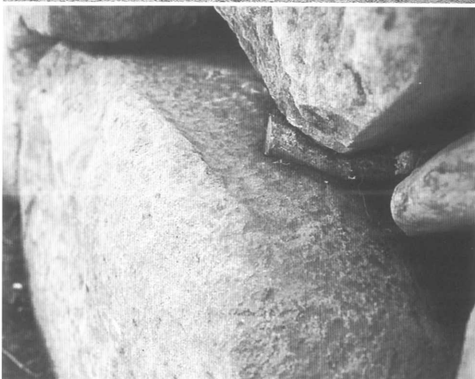
2. 同下段石列前面上部加工状态
