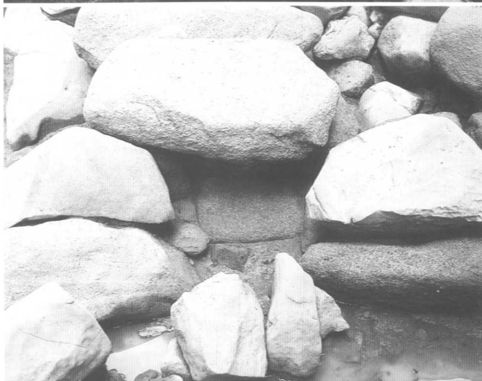
3. 同取水口（西から）
