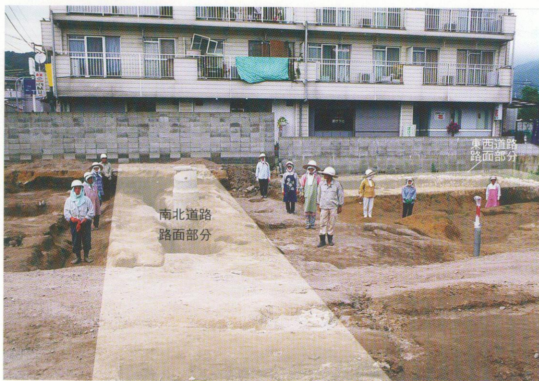
新道路の側溝に立ってもらいました。路面はすでに失われています。(南から撮影)
