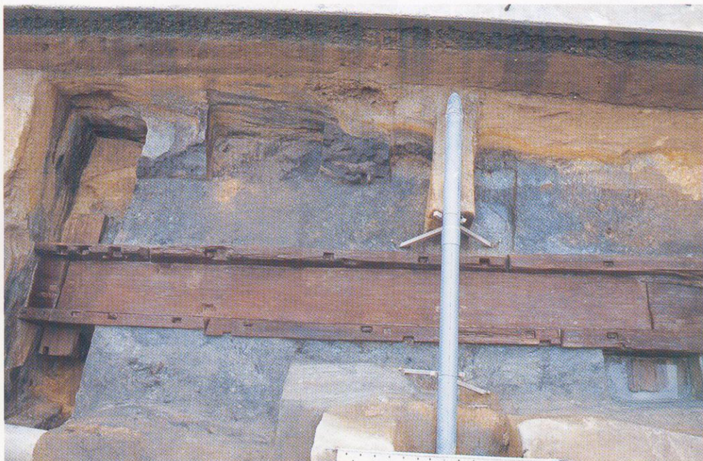
中央部木樋（西から）
