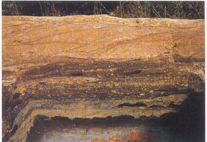
土塁中央部の積土状況①
