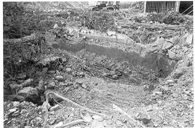
(4) 内野スタンド地下構造物撤去状況
