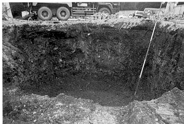
(5) 照明塔基礎撤去状況
