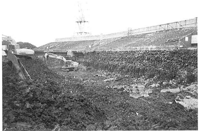
(2) 内野スタンド盛土撤去状況
