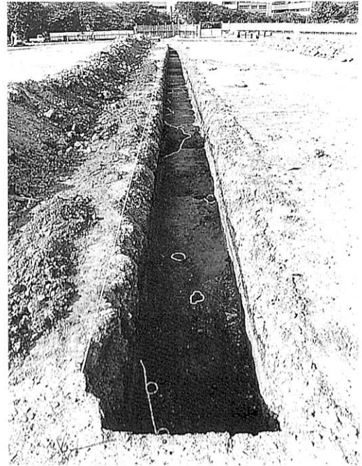
(2) 北トレンチ3 全景 (南から)
