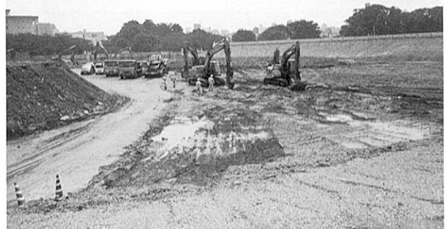
(4) グランド地下埋設管撤去状況
