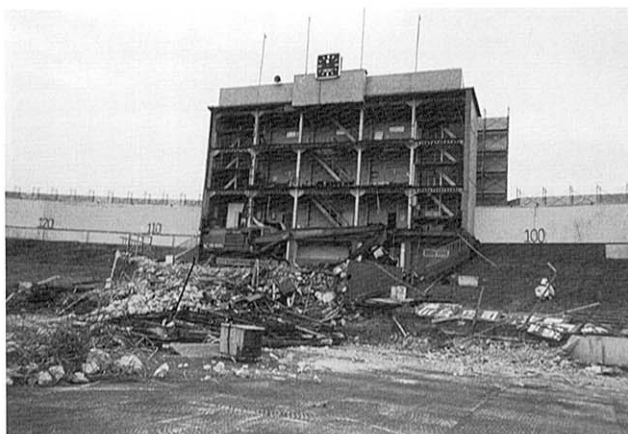
(5) スコアボード撤去状況
