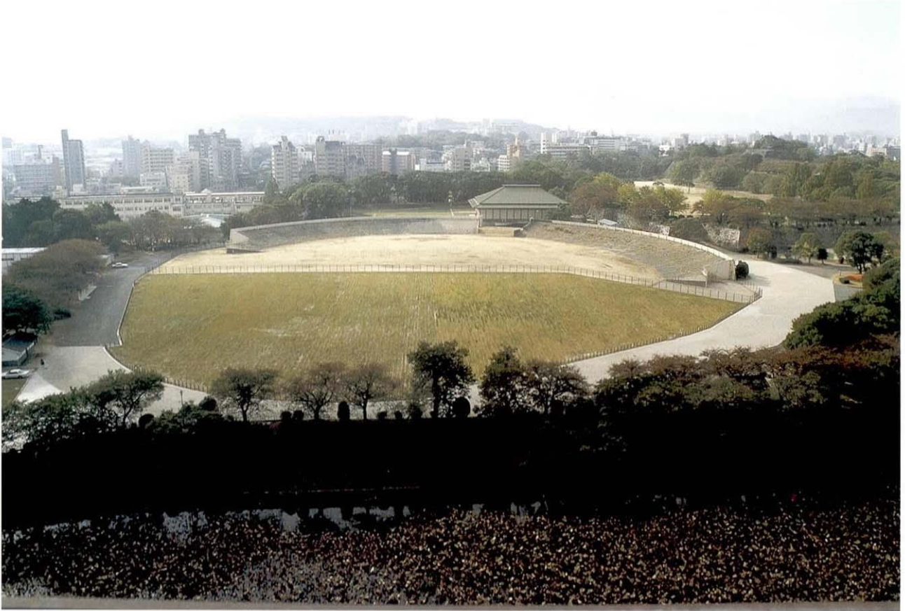
(1) 平和台野球場解体後の仮整備状況（北から）
