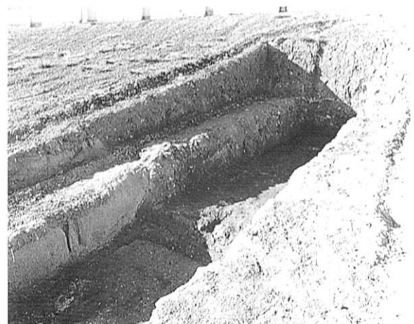
(6) 南トレンチ7 スタンド盛土状況（北から）
