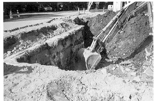
(6) 浄化槽撤去状況
