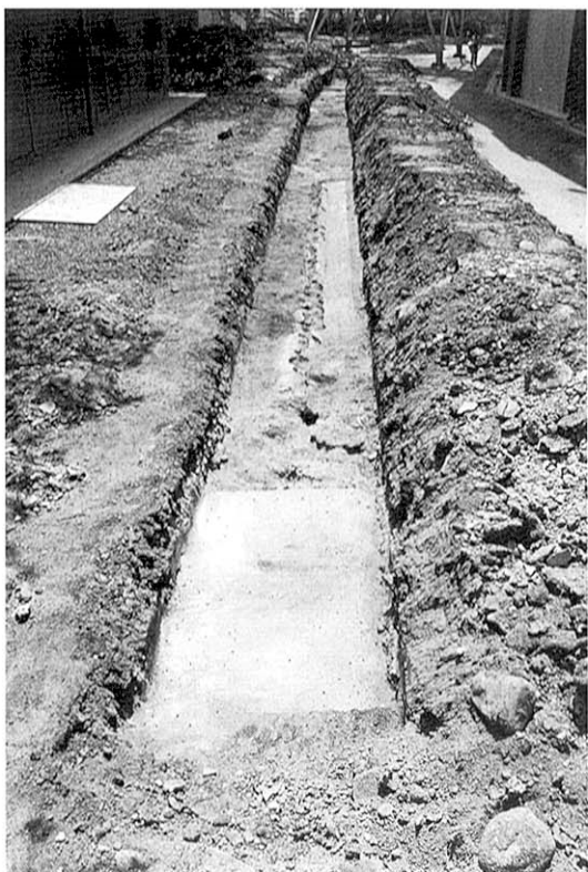
(5) トレンチ9 浄化槽検出状況（北から）
