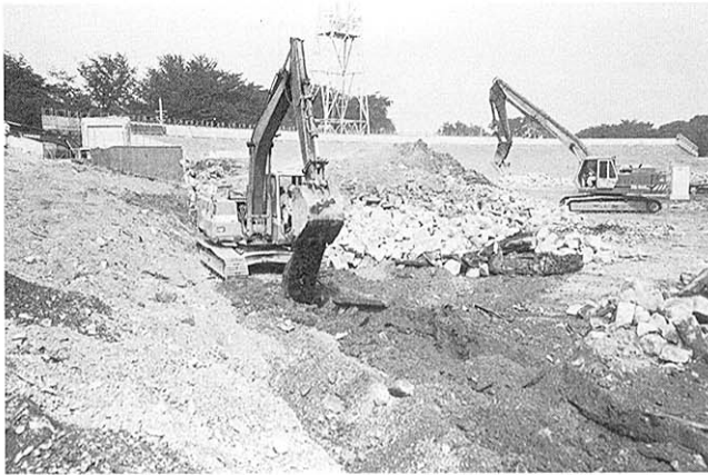
(1) 外野フェンス撤去状況
