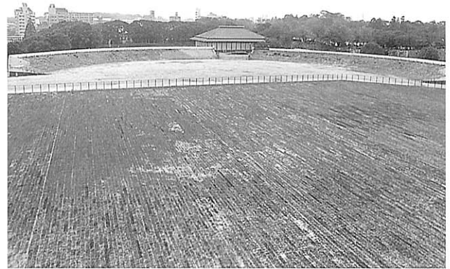
(2) 平和台野球場撤去後仮整備状況近景（北から）
