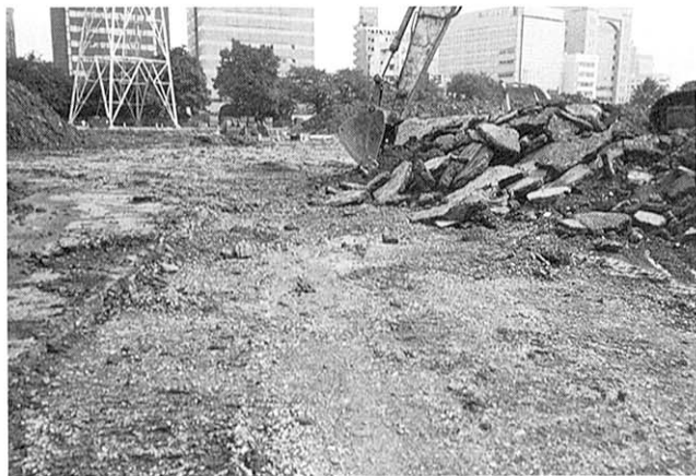
(3) グランド基礎撤去状況
