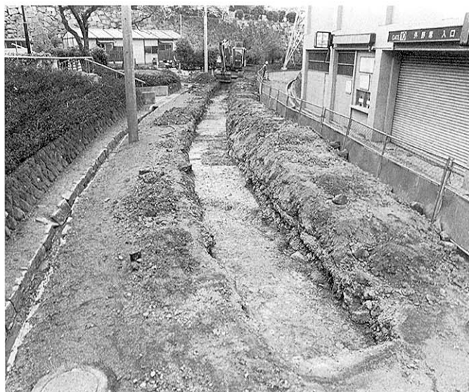
(1) 電気等切り替えにともなうトレンチ調査風景 トレンチ2（東から）
