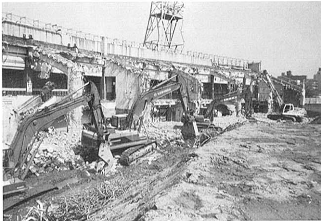
(3) 内野スタンド構造物撤去状況
