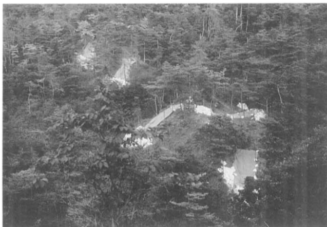
第13図 土塁線の調査状況
