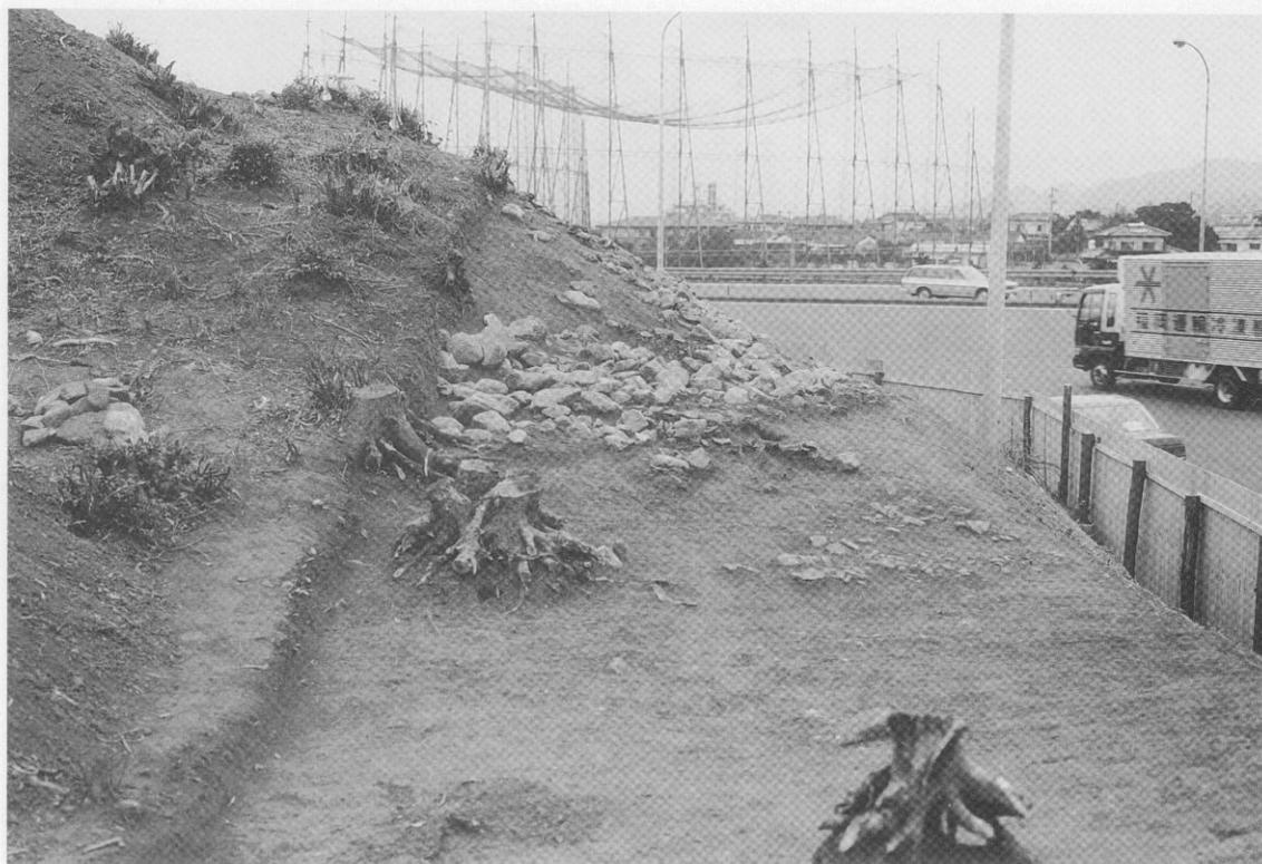
東側Ⅱ段斜面葺石崩壊状況（南東から）
