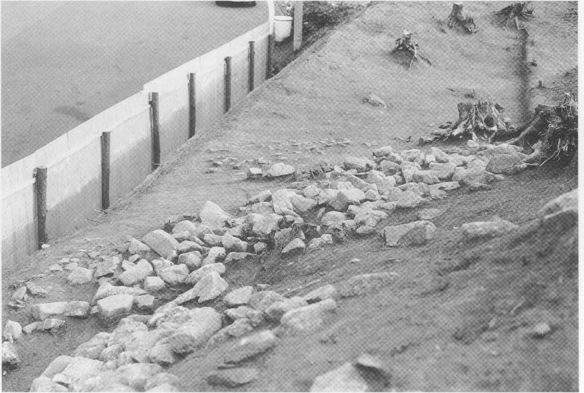
東側Ⅱ段斜面葺石崩壊状況（北西から）
