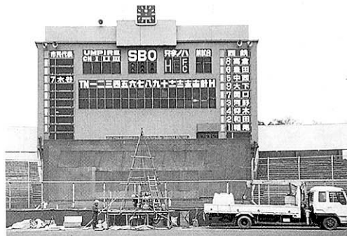
Fig. 4 平和台野球場内ボーリング調査（北から）
