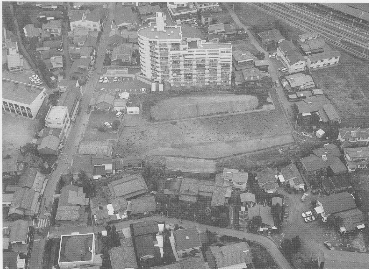
調査区全景（南より）
