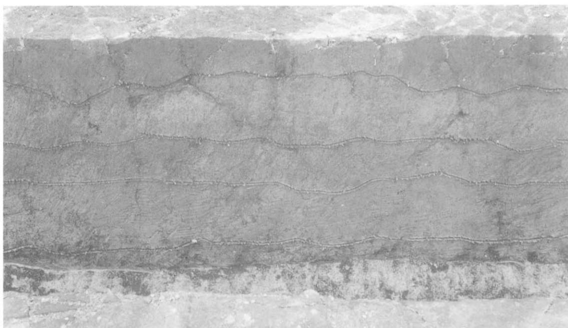
2. 土層断面③（南から）
