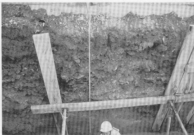
第2図 参道地下基盤土層
