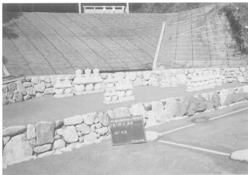
図版32 五輪塔設置状況
