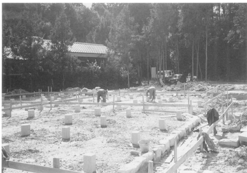
図版20 礎石柱建込工
