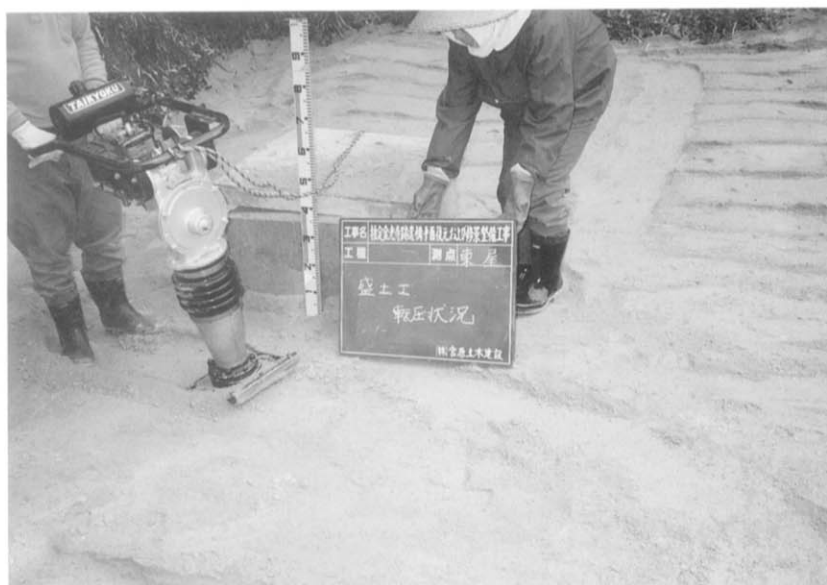
図版36 盛土転圧工
