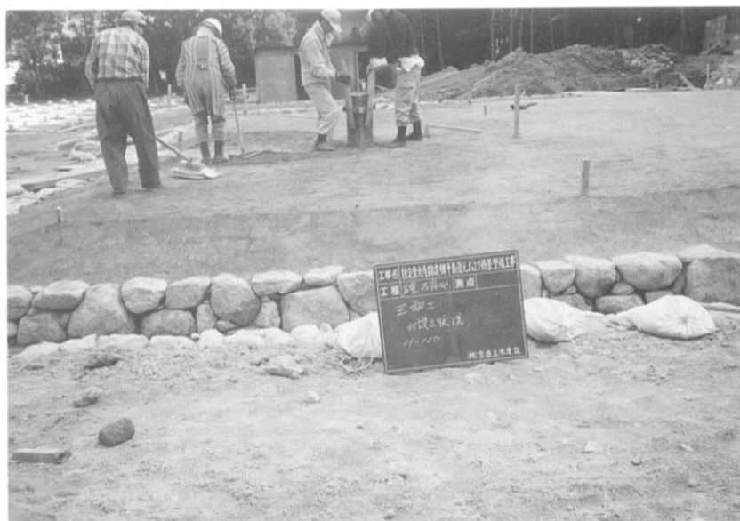
図版22 三和土転圧工
