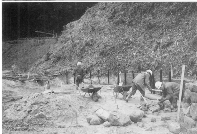
図版26 (上) 池石積工 (下) 池石積工及び竹細工
