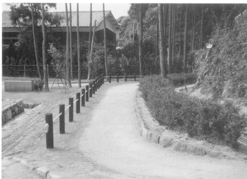
図版38 (上) 園路入口及び車止 (下) 園路及び安全柵
