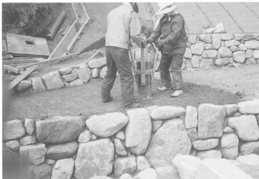
図版31 墓地三和土転圧工
