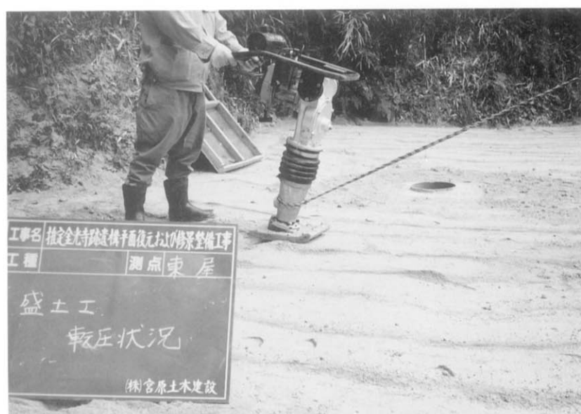
図版37 盛工転圧工
