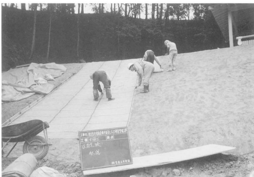
図版34 ローン帯張付工
