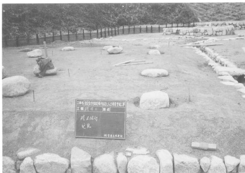
図版23 礎石据付工
