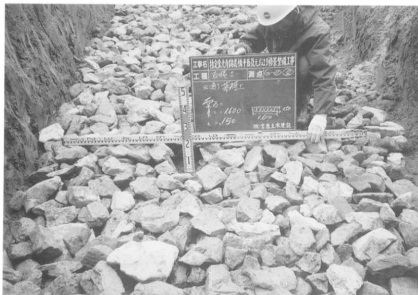
図版24 割栗石基礎工
