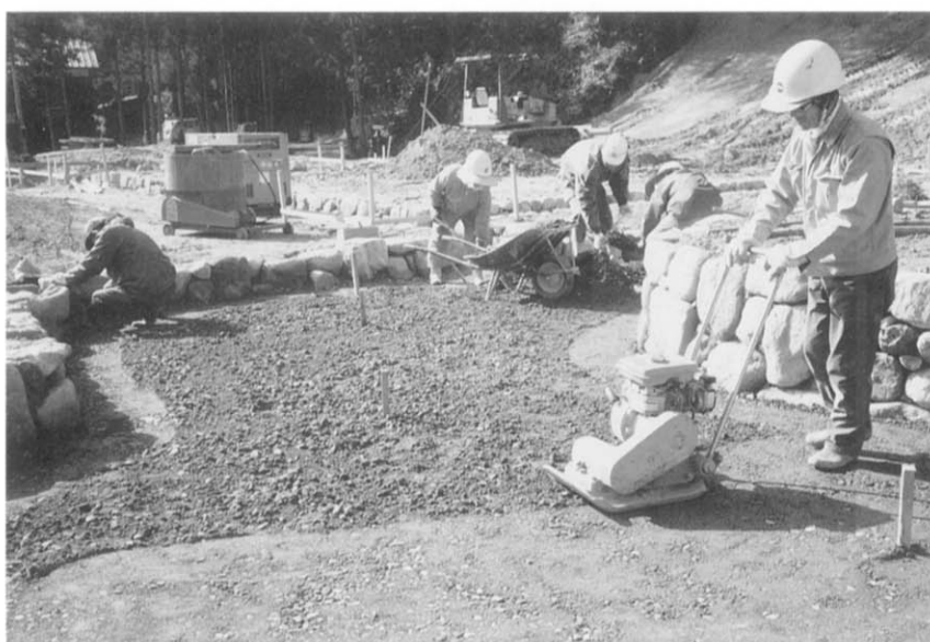
図版28 池床三和土転圧工
