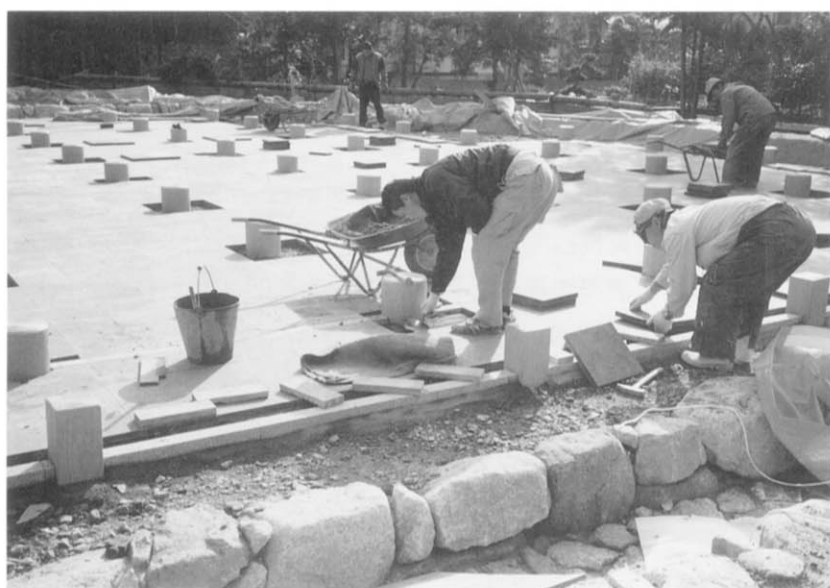
図版21 平板据付工
