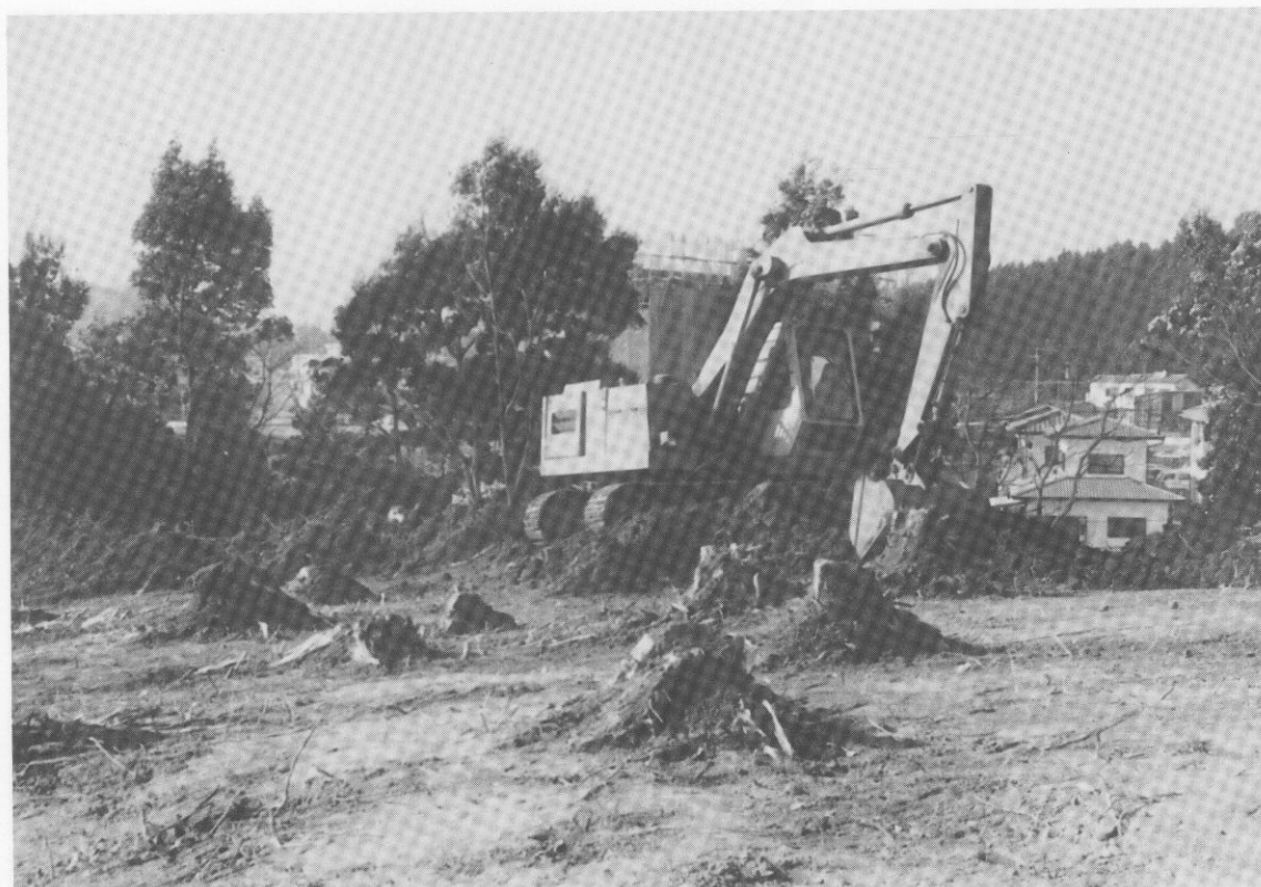
(2) 表土剥ぎ状況
