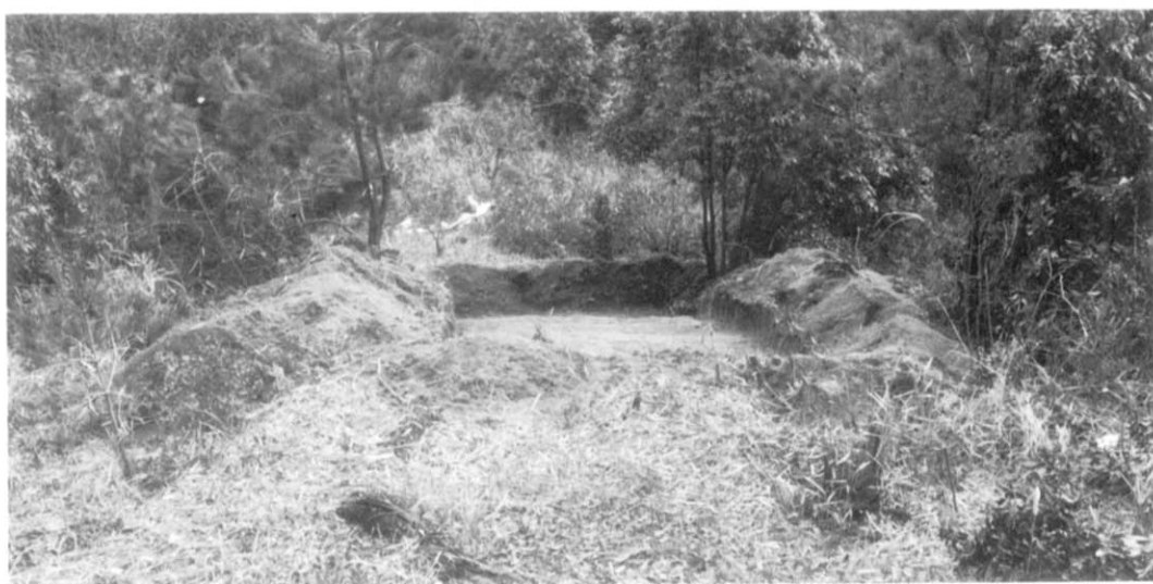
第 19 図 A トレンチ全景（西から）
