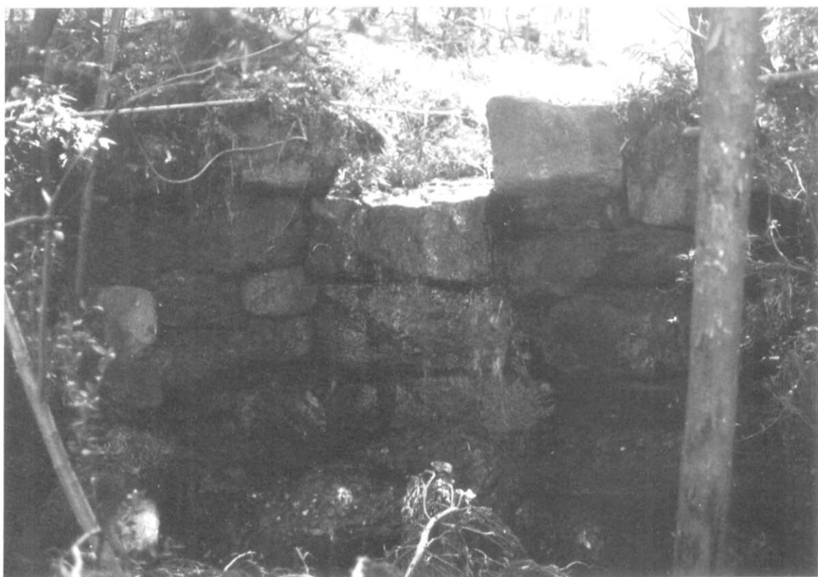
粥餅谷（横尾寺谷）水門の現状
