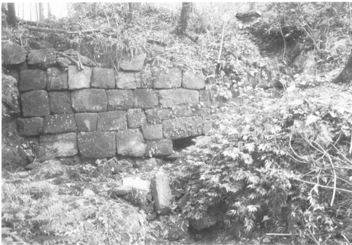
長谷水門の現状
