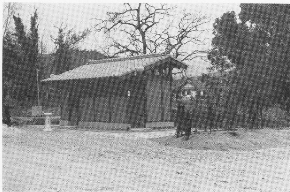
図版8 観世音寺広場の公衆便所新築工事
