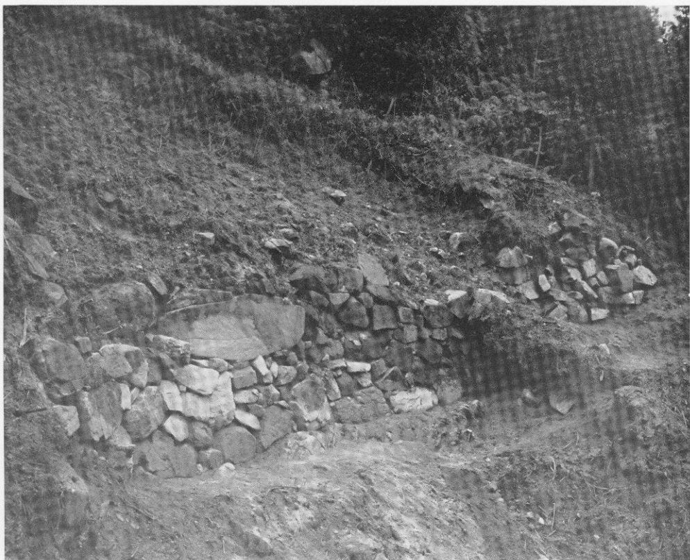
S A074—E 西谷状部分（C区）石垣
