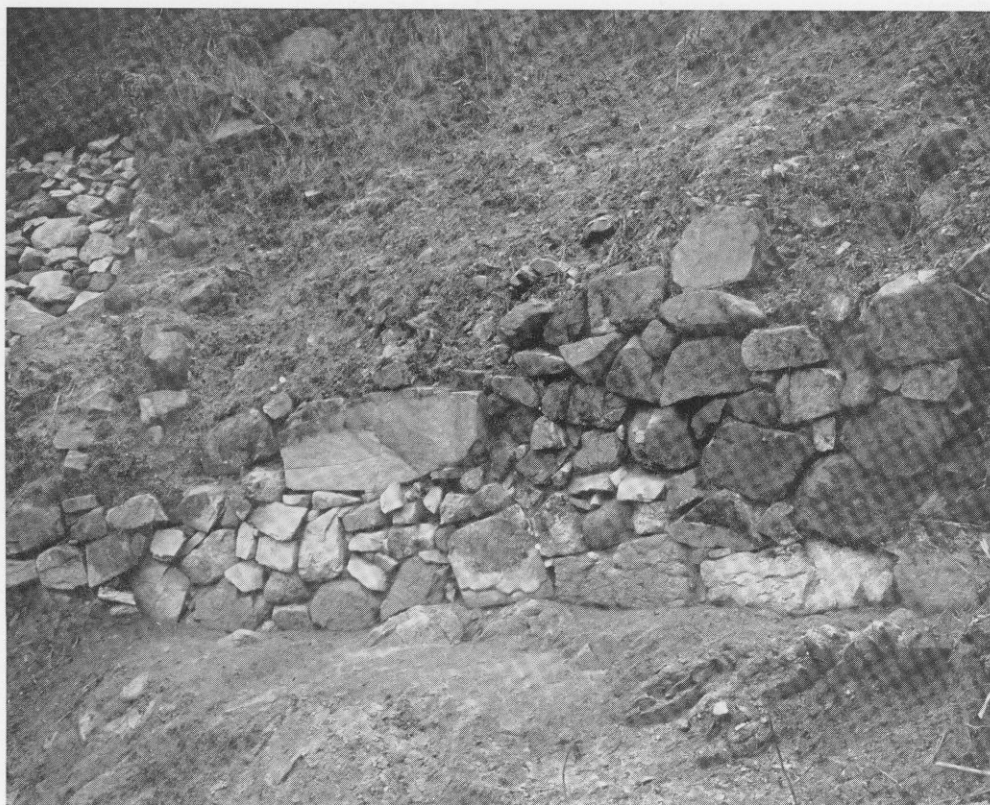
S A074—E 西谷状部分（C区）石垣
