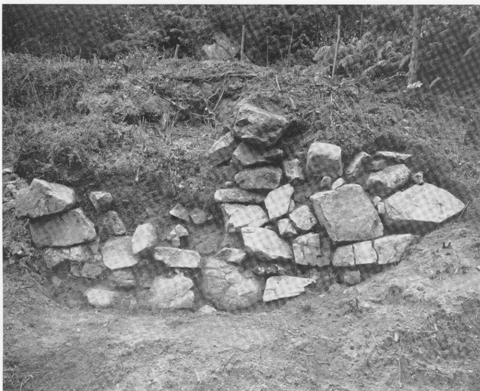
S A074—E 西谷状部分（C区）の西端部石垣
