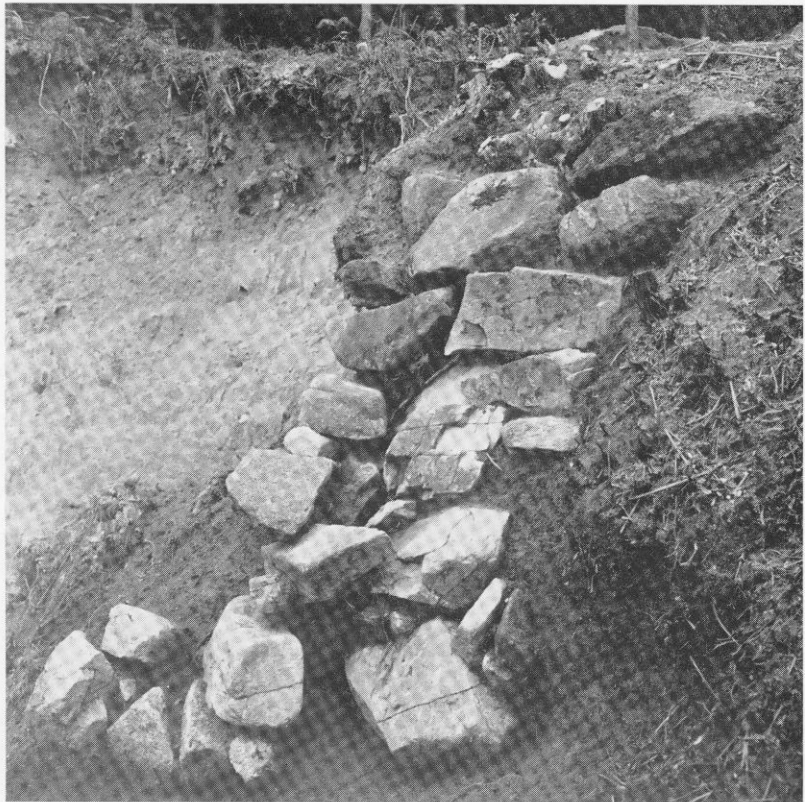
S A074—W 西端（D区）石垣と裏込めの版築
