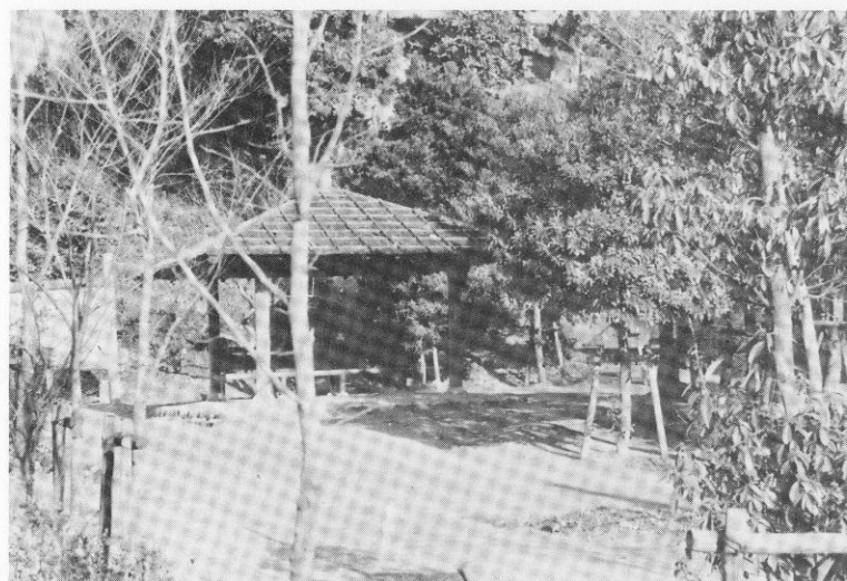
水城跡の環境整備 四阿新築、説明板設置、植栽工事、 その他活用施設
