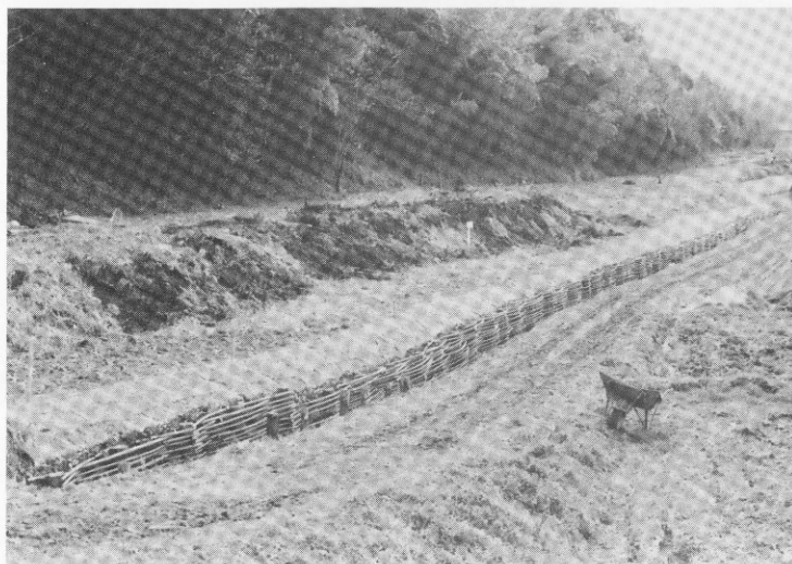
水城跡の環境整備 東堤部（国分側）保全防災工事
