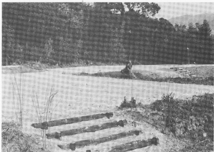
水城跡の環境整備 西堤部（吉松側）土堤保全修景
