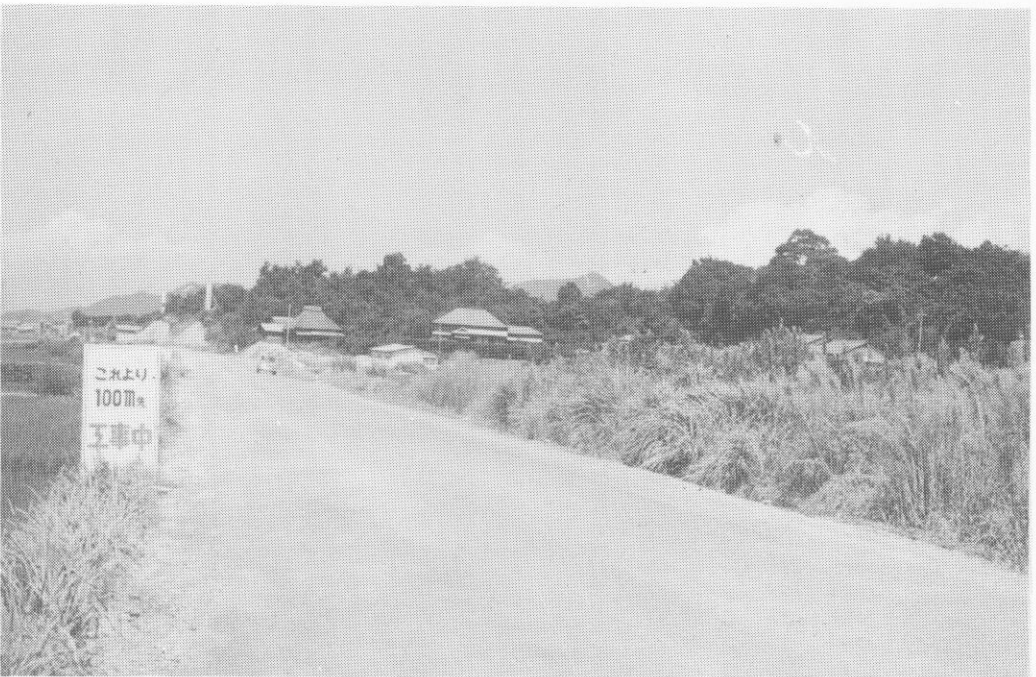
2. 遺跡付近遠景（南側道路より）
