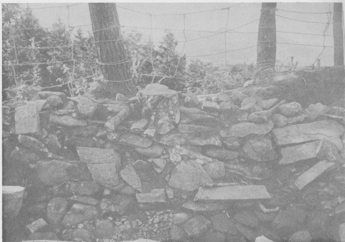
(1) 竪穴式石室南壁に天井部板石の附着してゐる状態
